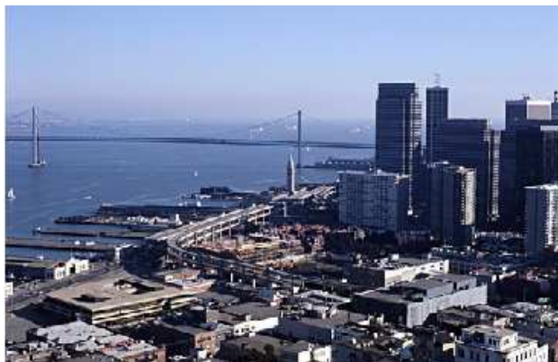
Figura 24 - Pier Freeway, São Francisco, na década de 80. Disponível em: www.archdaily.com.br/br . Acesso em 10 set. 2015.
